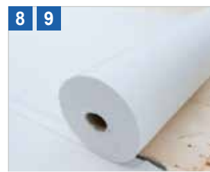
8) Erste Lage Vlies - 9) 22,5 x 96 mm Faserbretter Holzschalungsfläche
