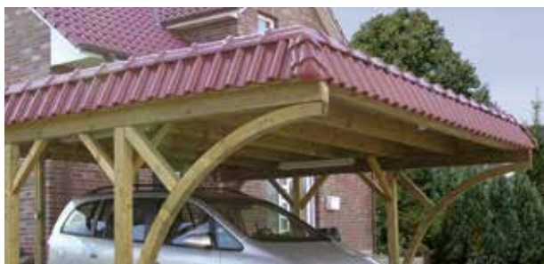
Breite Einfahrt: Pfostenbögen aus Leimholz
